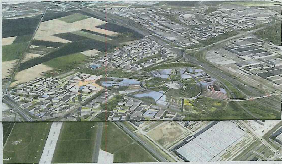
Destruction de ressources, atteinte à la biodiversité, doutes sur la création des 8.000 emplois annoncés... Les conclusions de l'enquête publique mettent à mal le projet d'urbanisation du Triangle de Gonesse.
